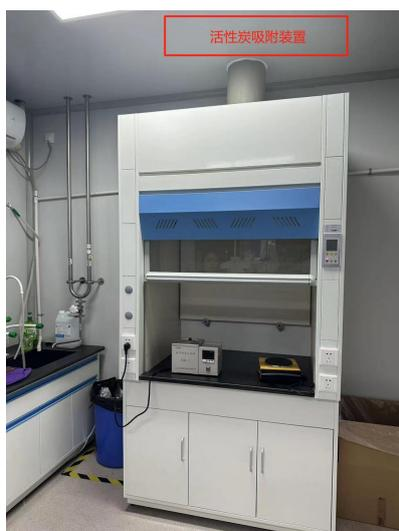
图 6-1 检验室内通风橱、管道、活性炭吸附装置位置示意图
